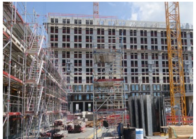
Bahnstadt, B1.3 fortgeschrittene Bauphase des Hotels Atlantic
