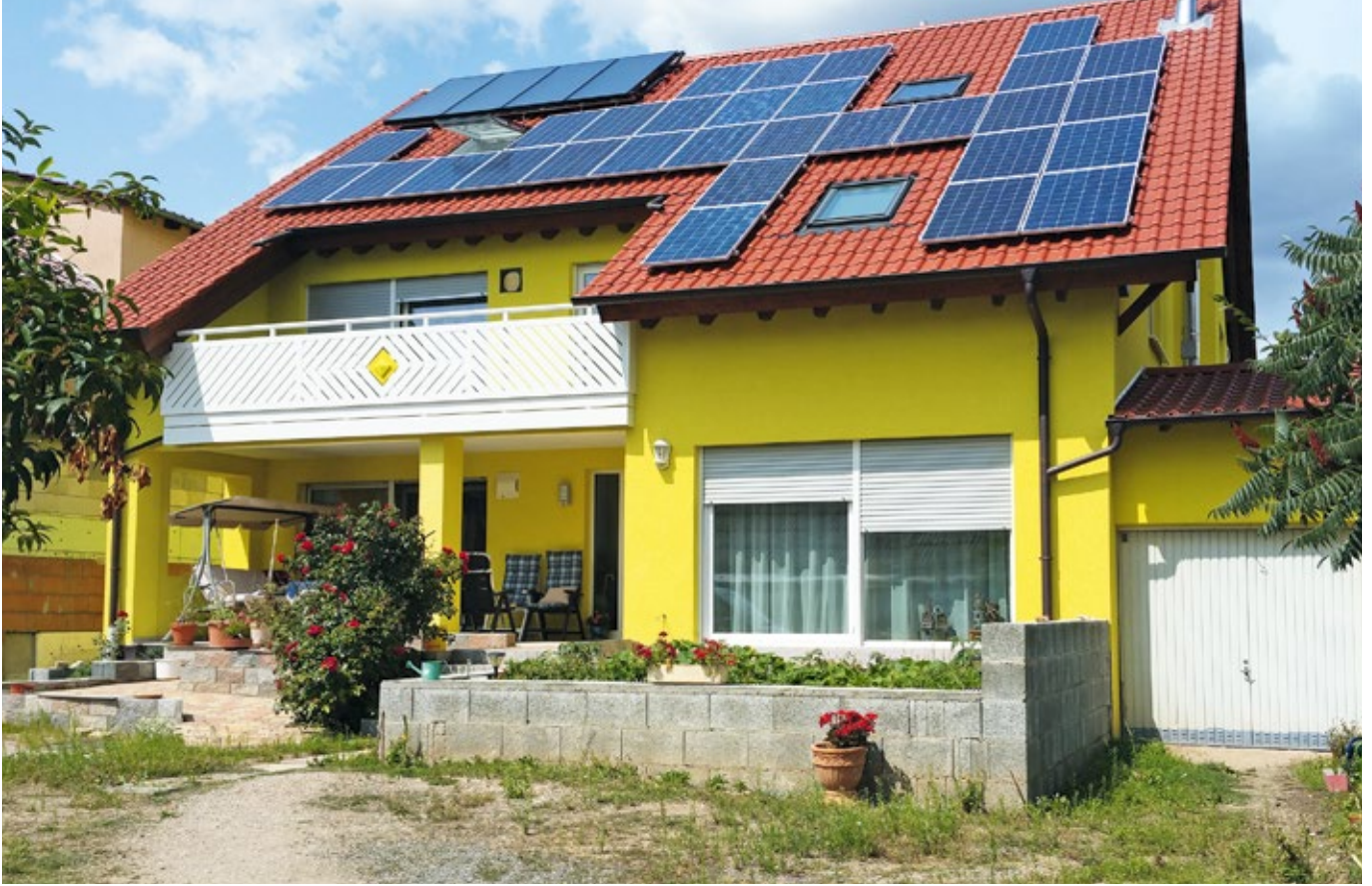
Das Haus als Kraftwerk – eine komplette energetische Sanierung eines Zweifamilienhauses in Schriesheim: von der Kellerdecke bis zum Dach mit Solarthermie für Heiz-/Brauchwasser und einer PV-Anlage
